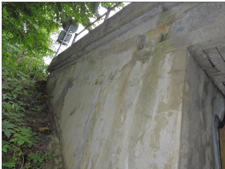
Trhliny, výluhy, inkrustace - křídlo č. 1, pravá strana
