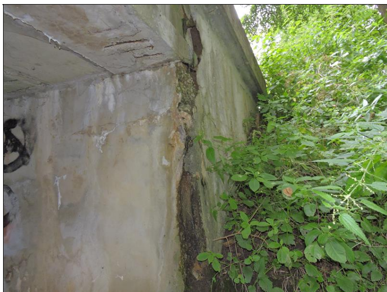
Degradace betonu, zamáčení, vyluhy a celkový rozpad levého horního rohu OP1
