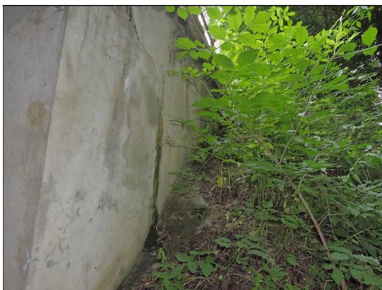
Trhlina, zavlhání, inkrustace - křídlo č. 2, pravá strana
