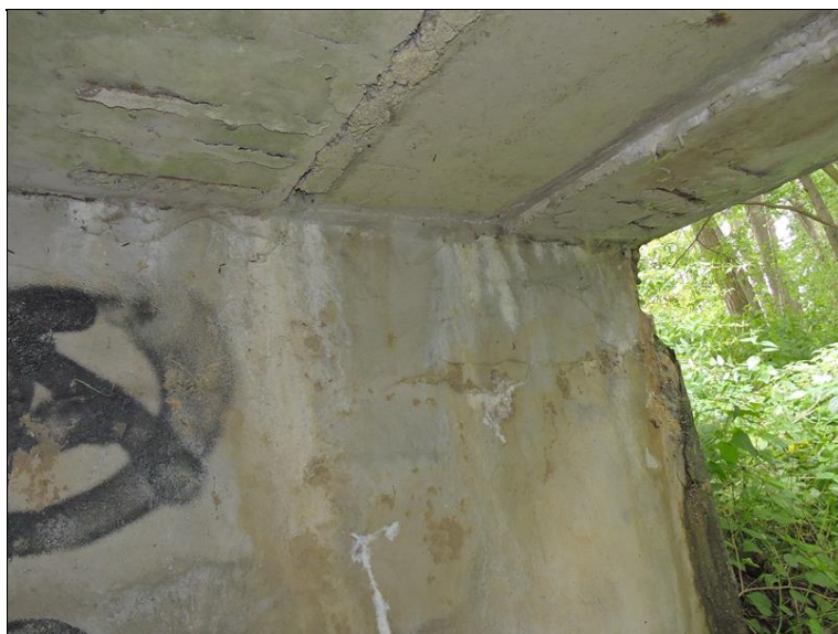
Zatékání v místě uložení s inkrustací a vyluhy - levá strana OP1
